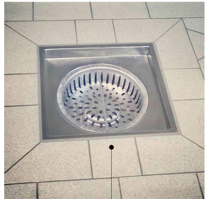
Detail polaganja keramike: Keramiko v oddaljenosti 1m od talne rešetke je potrebno položiti s padcem 1% proti talni rešetki.
